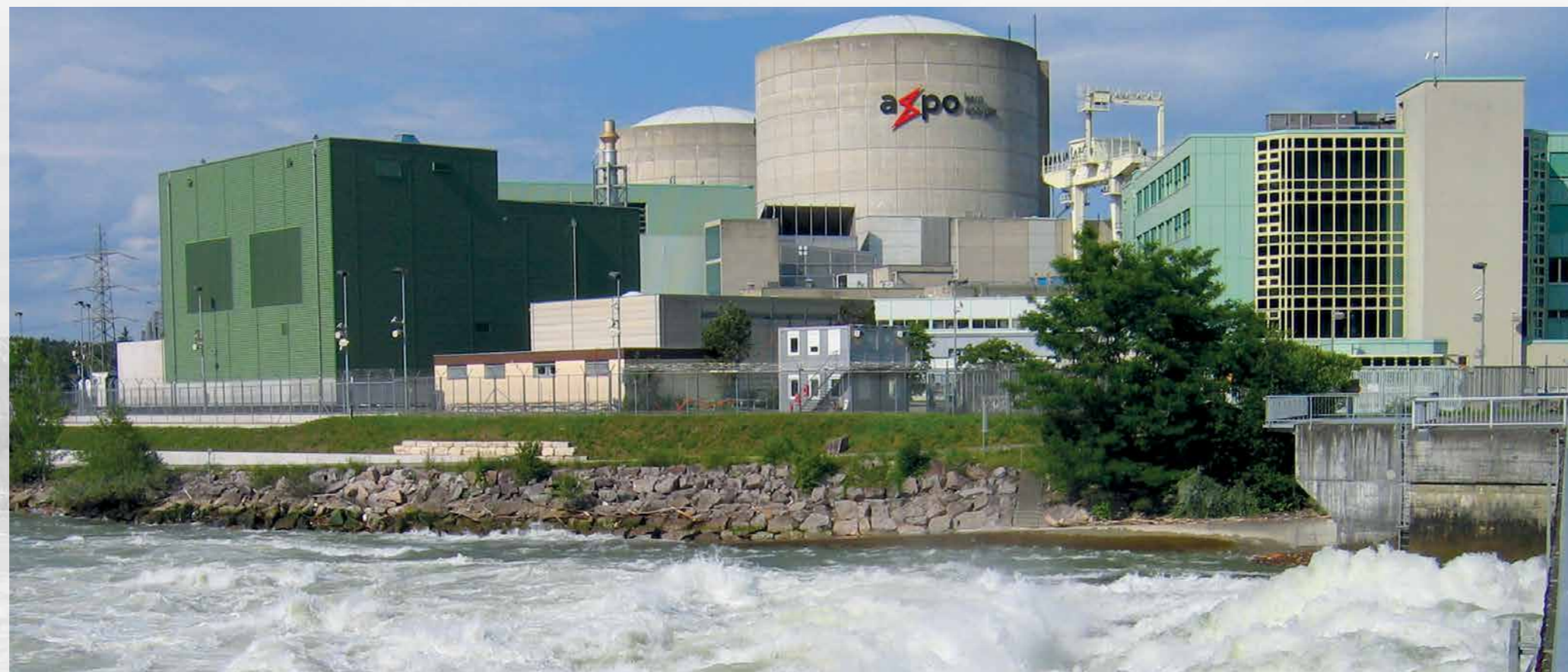
Atomkraftwerk Beznau I und II. Reaktor I hält einen unrühmlichen Rekord: Er ist mit fast 52 Jahren der weltweit älteste in Betrieb.
